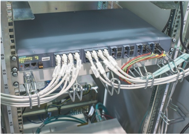
Die managed Switches SCALANCE XR528-6M mit Device Netzwerk-Management von Siemens sind mit einer 1Gbit-Leitung verbunden.
