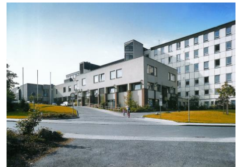
Die Klinikum Arnsberg GmbH rüstete die Elektroinstallation am Standort Karolinen-Hospital Hüsten mit zehn Brandschutzschaltern von Siemens nach.
