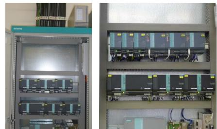
*Bild 1: Bei diesem Schaltschrank zur Steuerung einer Krananlage wurde eine AC-USV, die auf Grund ihrer Größe auf dem Schrank montiert werden musste (linkes Foto), durch 3 DC-USVen ersetzt. Weil zugleich die kompaktere Netzgeräte-Generation SITOP PSU300M 24 V/ 20 A eingesetzt wurde, passten sogar alle 3 Stromversorgungen mit den 3 SITOP UPS500S 15A/5 kW auf dieselbe Hutschiene.*
