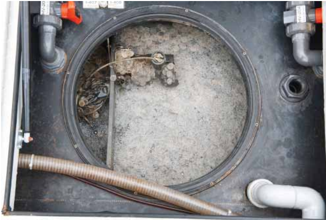
Das „Moving Bed“ des Bioreaktors bilden sog. Aufbauträger, frei in den Behältern schwimmende Kunststoffchips für die Bakterienbiologie.
