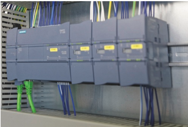
Kompakte Automatisierungslösung mit Bestandsschutzpotential: Der Controller SIMATIC S7-1200 kann mit Hilfe des Kommunikationsprozessors CP 1243-8 IRC (ganz links) nahtlos an das vorhandene Fernwerkssystem angebunden werden.
