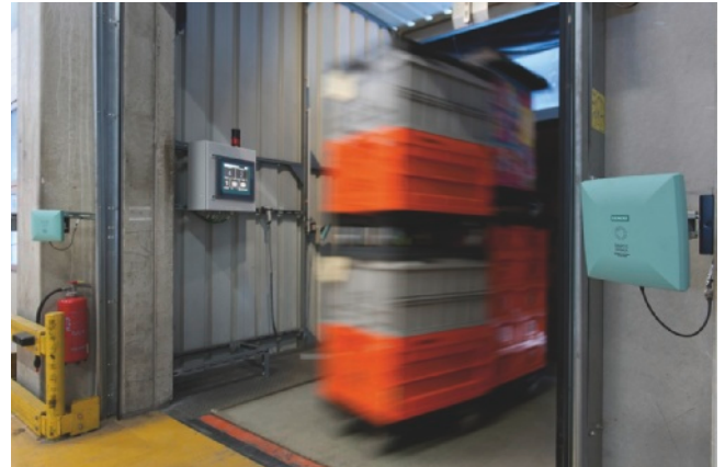
Bild 2: Zwei über Bewegungsmelder aktivierte RFID-Antennenpaare lesen berührungslos die Transponder/Tags an den Dollys aus und erkennen dabei die Richtigkeit der Ware und die Laderichtung
